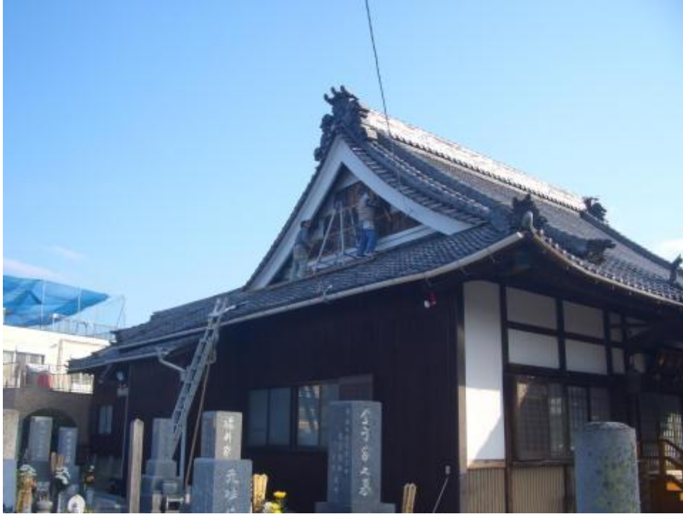
本堂西側外壁のトタン板修理工事平成25年12月4日撮影
