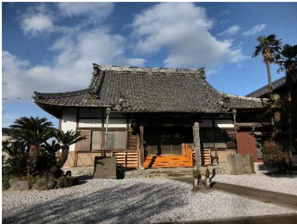
普仙寺本堂 平成27年12月5日撮影
