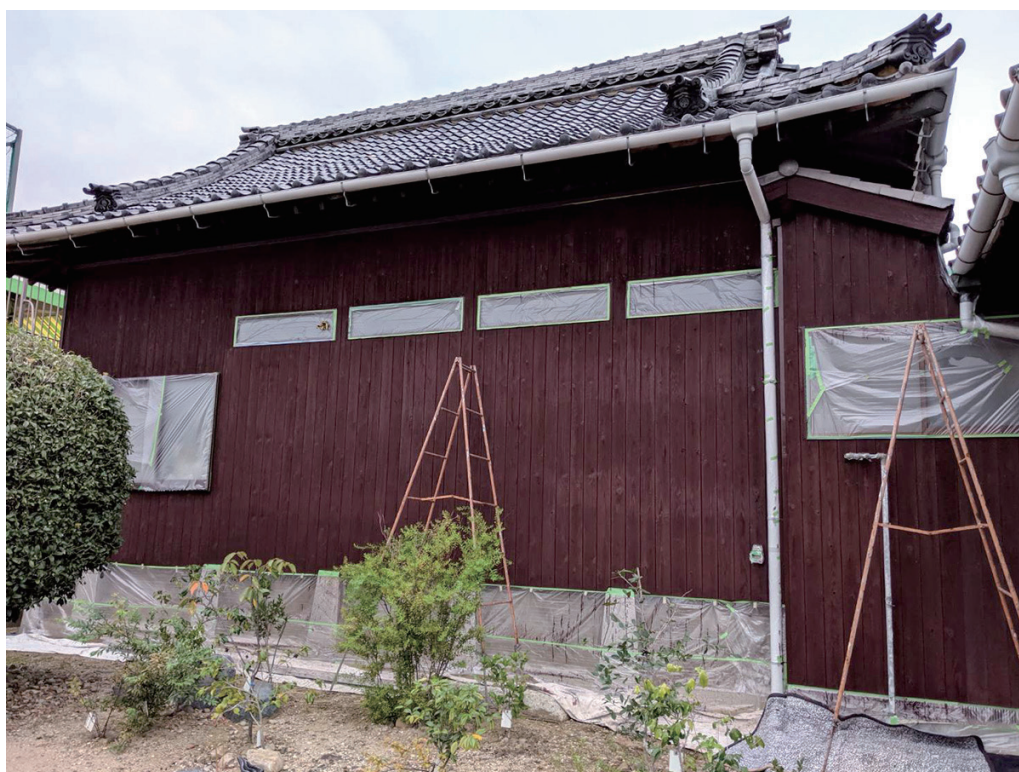
普仙寺本堂と位牌堂のペンキ修理を行いました。 令和2年10月1日撮影（位牌堂）
